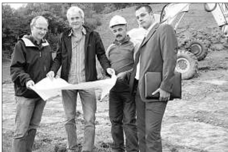
Spatenstich für die neue Quartierserschliessung: Gian-Reto Paterlini, Curdin Luzzi, Nicola Mammone, Philipp Liesch (v. l.). (zVg)
