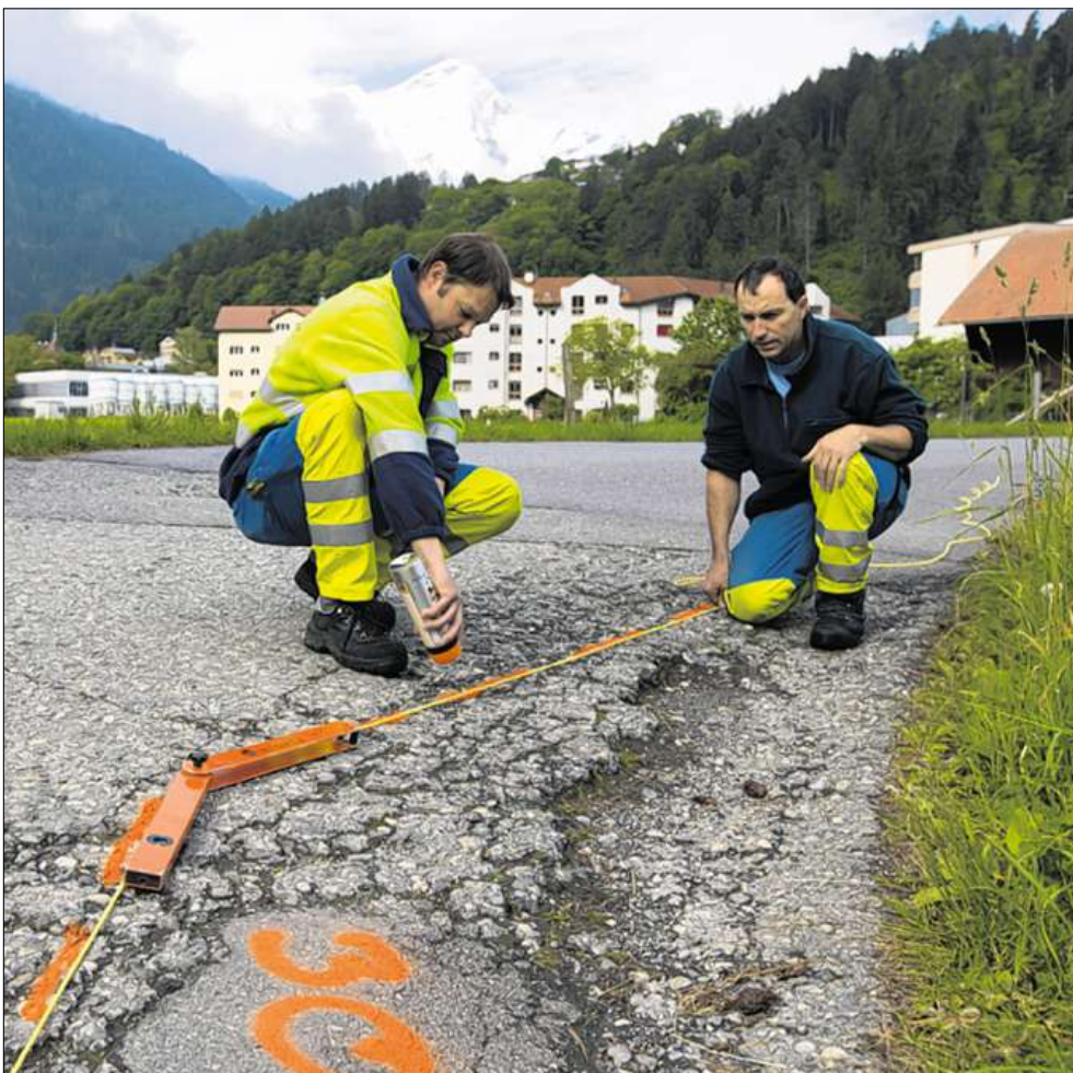
Vor Baubeginn muss die Linienführung der Erdgas-Versorgungsleitung aufgezeichnet werden.
